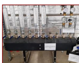
Rozdzielacz dystrybujący ciepło do wysp socjalnych
